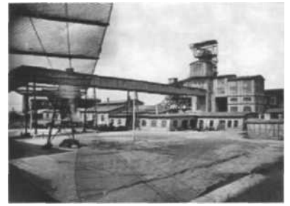
Abb. 7: Schutznetz der Seilbahntrasse im Bereich des Wolf-Schachtes
