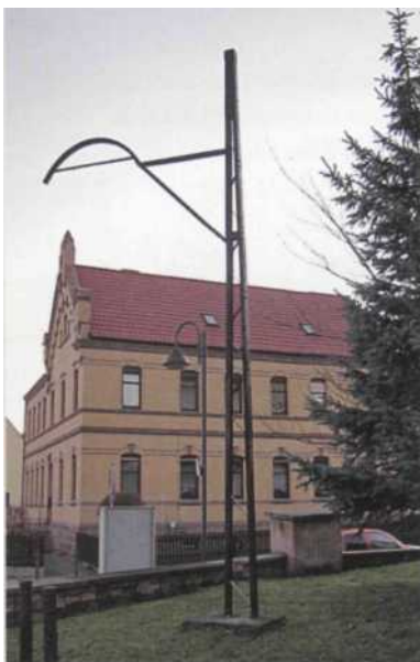
Abb. 33: Originalmast der Elektrischen Kleinbahn in Helfta
