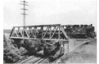
Abb. 18: Lok 20 auf Brücke 27
