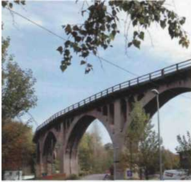
Abb. 22: Die Bogenbrücke über den Schmalzgrund in Hettstedt
