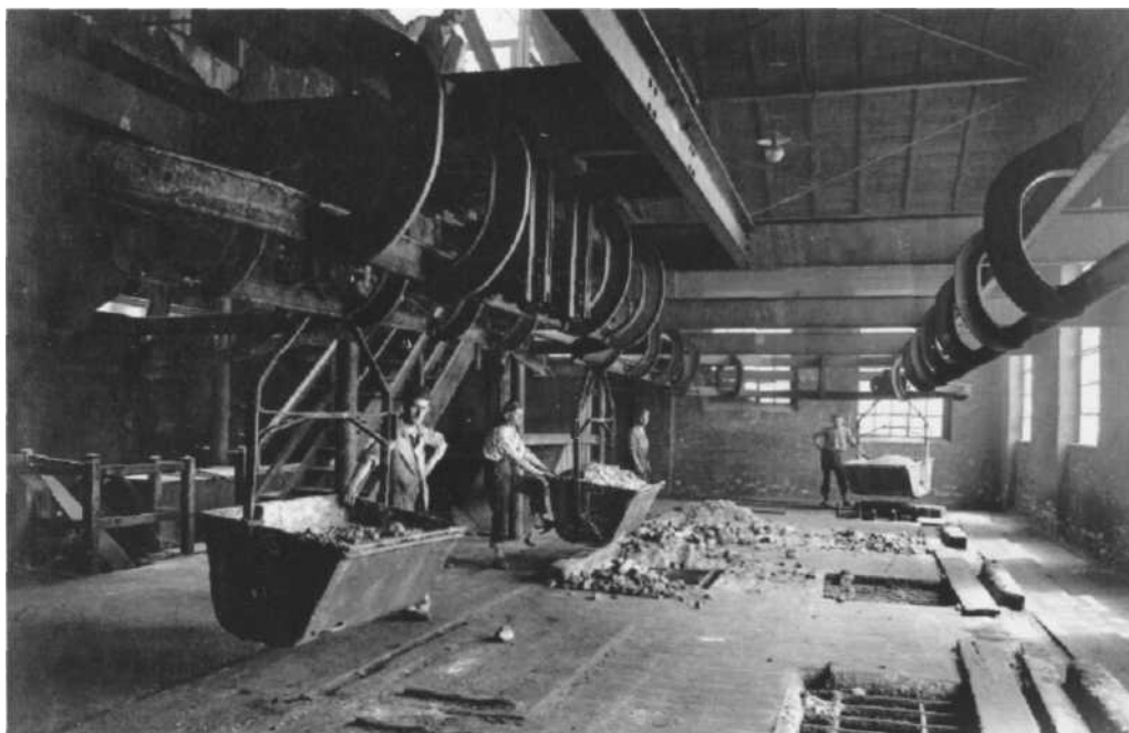
Abb. 8: Entladung von Salzkübeln in der Kalifabrik Eisleben
