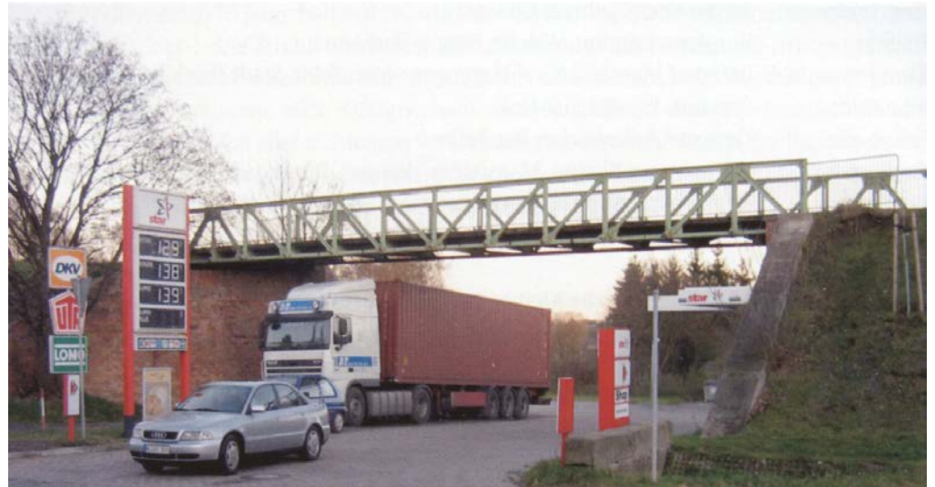
Abb. 31: Brücke zwischen Helbra und Benndorf
